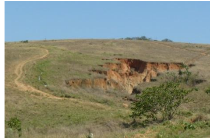
Figura 15 – Ravinamento ao longo da R605 (Tsangano-Sede)
