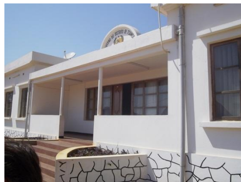
Figura 20 – Edifício do Governo Distrital
