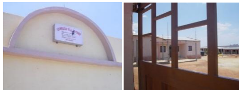
Figura 37 – Nova Infra-Estrutura de Serviços (Vila de Tsangano)
